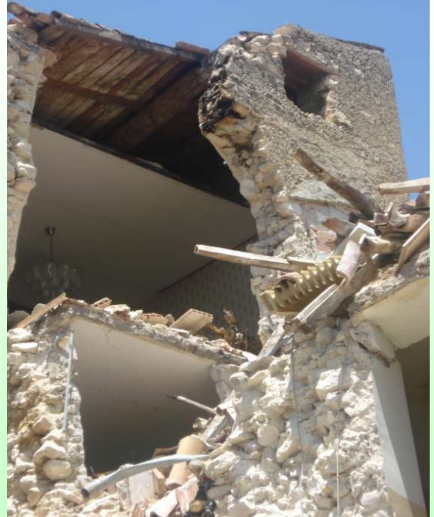
Meccanismo C ribaltamento del cantonale
