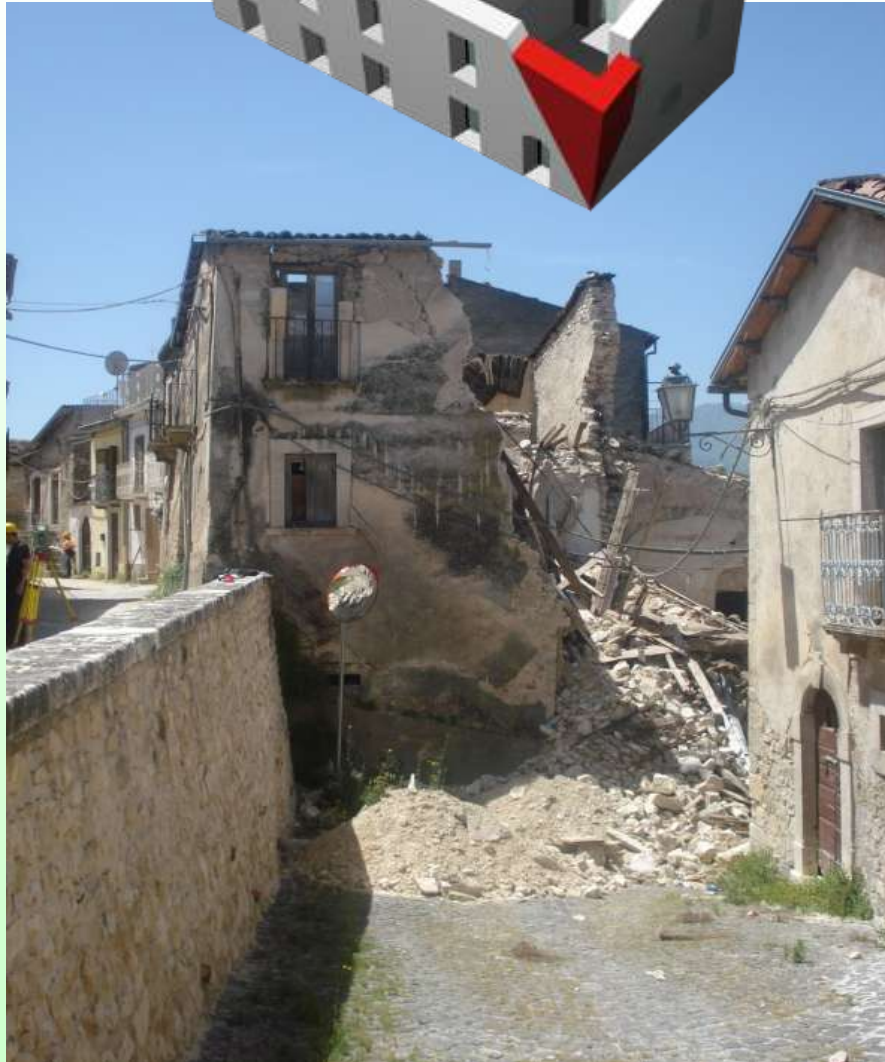
Meccanismo C ribaltamento del cantonale
